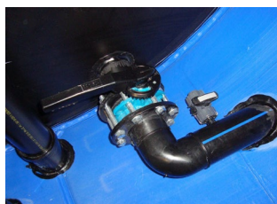
Trinkwassertank 12500 L mit montierter Tauchpumpe, Domschacht ist mit Aluminium ummantelt Citerne pour eau potable 12500 L avec pompe immergée et trou d'homme enrobé d'aluminium
